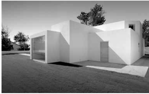
2000, Casa Francisco Ramos Pinto, Francelos, Portugal Francisco Ramos Pinto House, Francelos, Portugal
